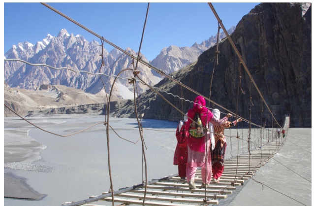
写真5 フセイニ村と村の出作り農地のある対岸のザラバードを結ぶ吊り橋。フンザ川に架かるこの吊り橋は、全長約 200m あり、世界一危険な橋として紹介されている。住民（女性）たちは朝この吊り橋を渡り、農作業を終えた後に村に帰る。筆者もザラードの調査のため、何度となくこの吊り橋を利用した。
